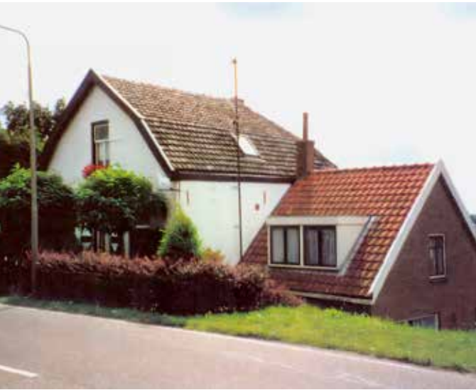
Voormalig café ‘Het Witte Paard’ gezien vanaf de Veersedijk, Veersedijk nr. 80 ca. 2009
