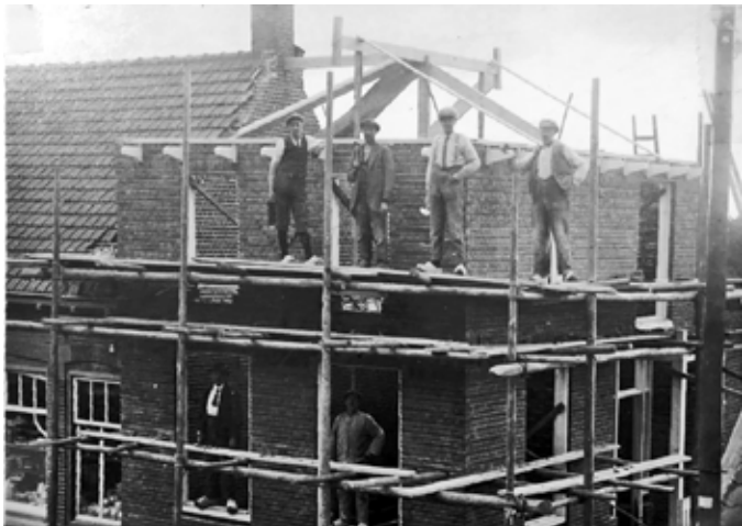
De woning in aanbouw
