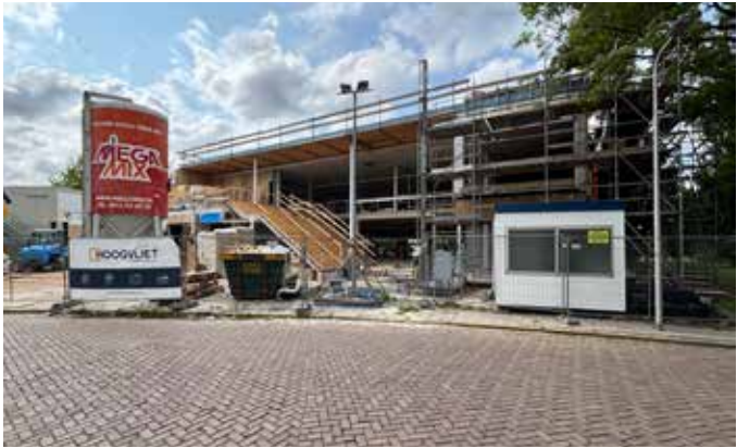
De nieuwbouw (juli 2025) van de Toermalijn aan de Schaepmanlaan. Foto auteur
