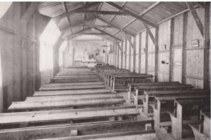
Een blik in de noodkerk gezien vanaf de uitgang. Collectie Bastiaan Los
